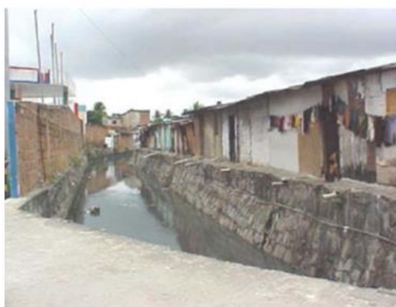
Comunidade instalada à margem de canal (bairro de Afogados)
