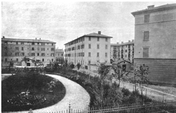
Figura 5 Vista do primeiro conjunto construído pelo IACP de Bolonha em 1918 FONTE: IACP (1911)
