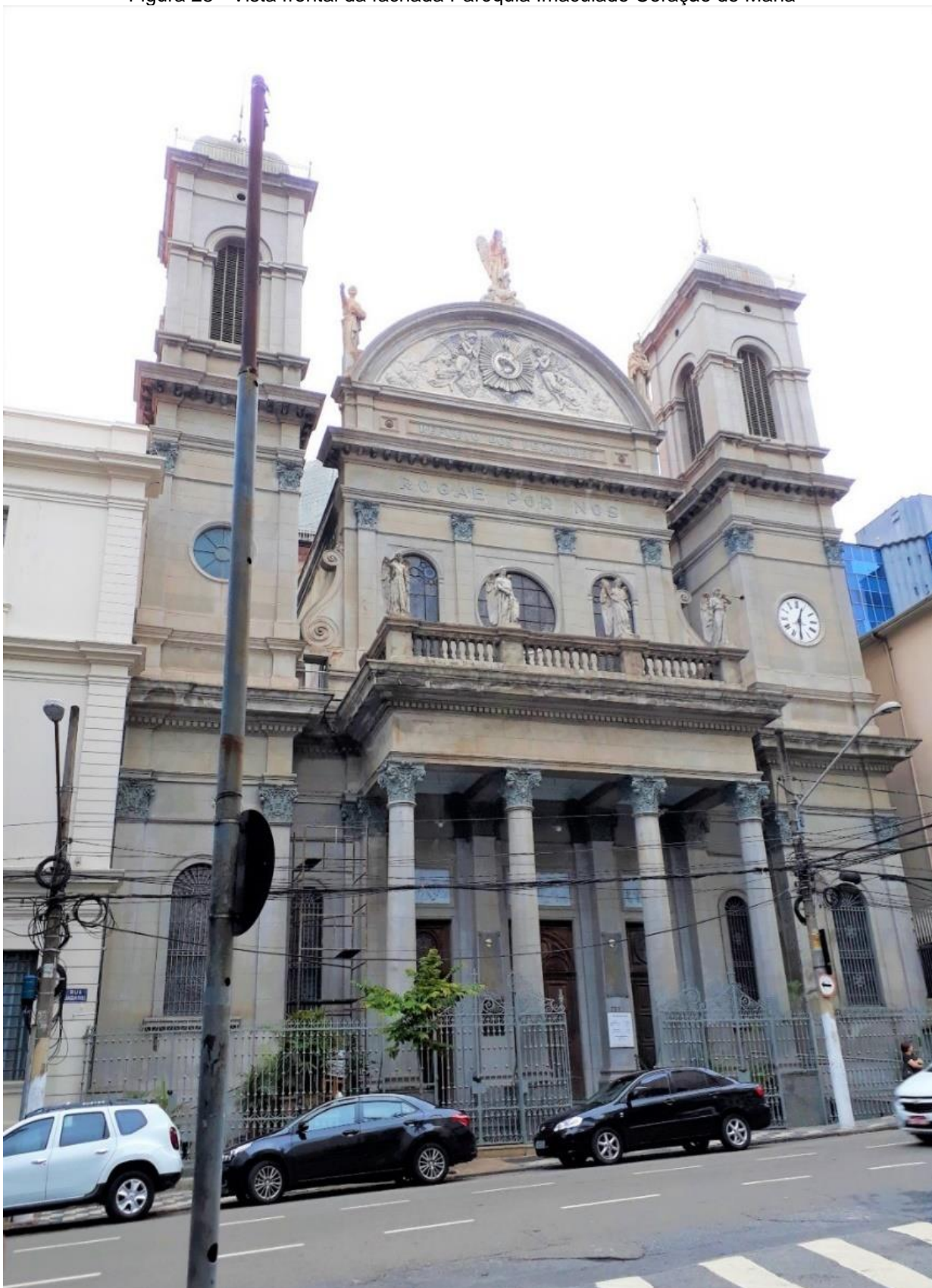
Figura 28 - Vista frontal da fachada Paróquia Imaculado Coração de Maria
