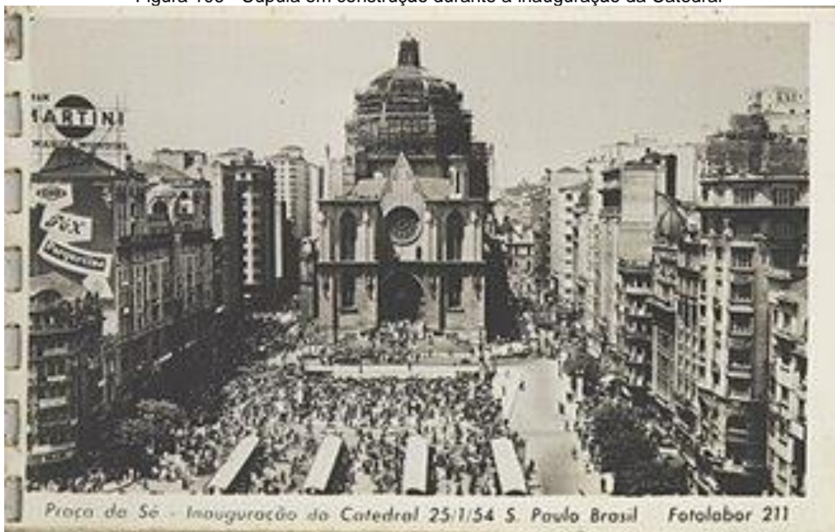
Figura 106 - Cúpula em construção durante a inauguração da Catedral
