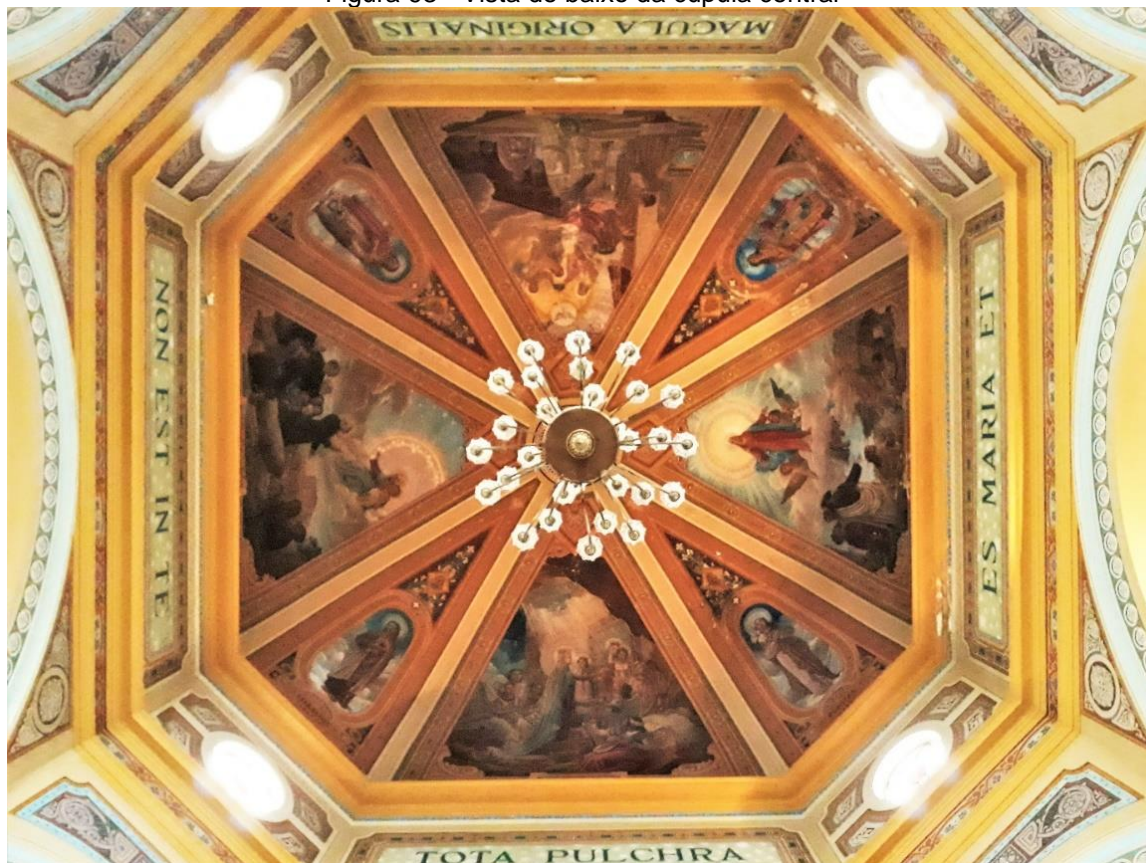
Figura 93 - Vista de baixo da cúpula central
