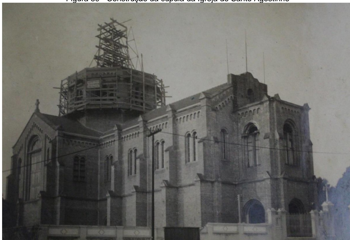
Figura 59 - Construção da cúpula da Igreja de Santo Agostinho
