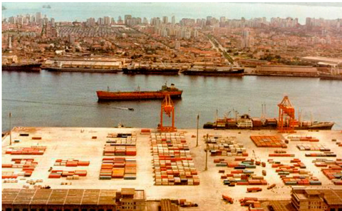
Imagem 14. Terminal de Contêineres da margem esquerda do Porto de Santos (Tecon), um ano após a inauguração
