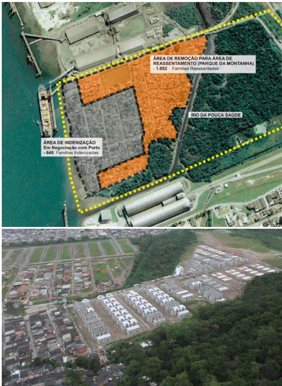
Imagem 34 – Diretriz do projeto de remoção das famílias do Sítio Conceiçãozinha e vista do conjunto habitacional Parque da Montanha em construção
