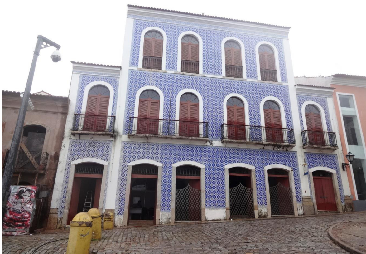
Figura 24 – Casarão restaurado. Fonte: Autoria própria
