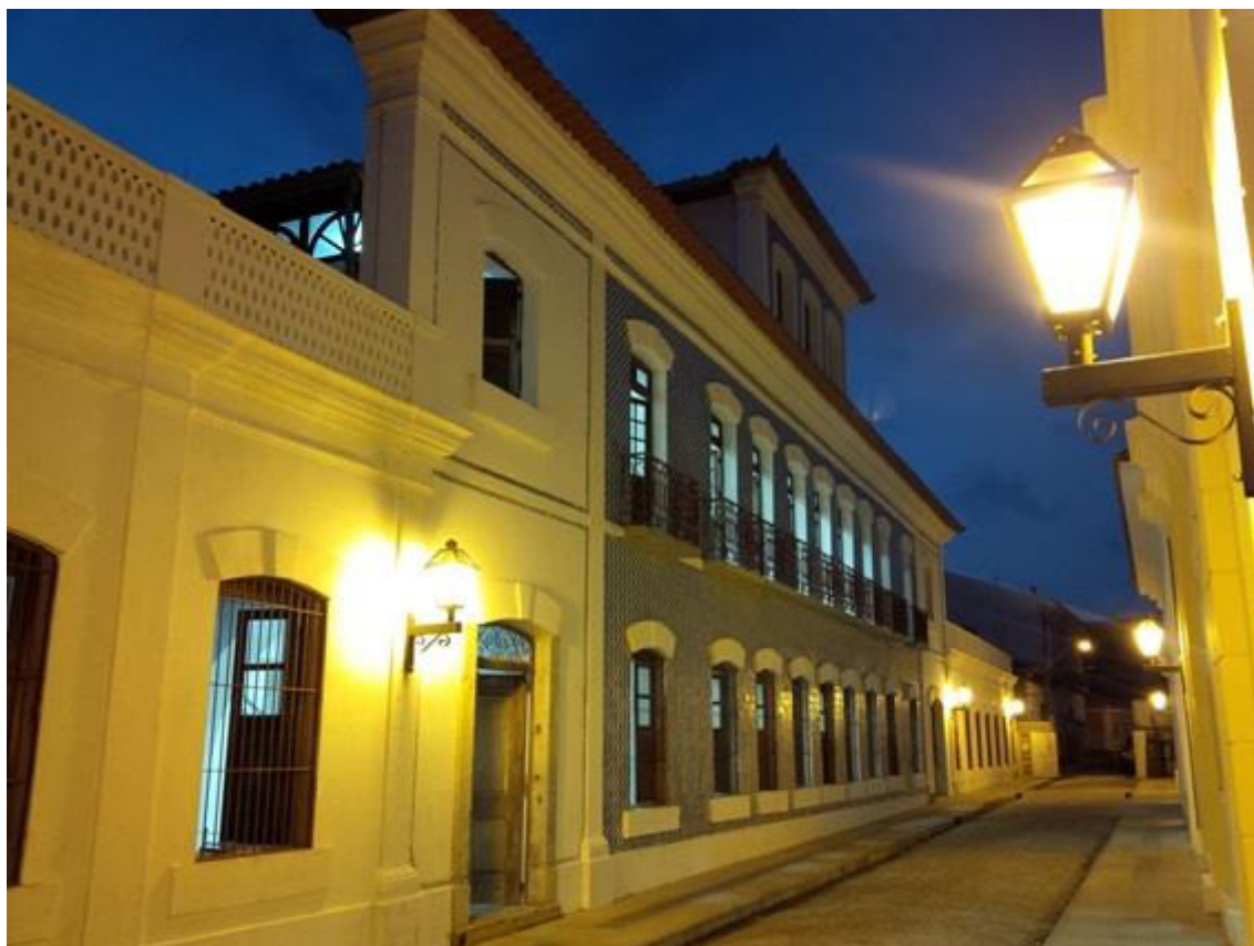
Figura 22 - Fábrica Santa Amélia restaurada (2015). Fonte: http://portal.iphan.gov.br/noticias/detalhes/3316/fabrica-santa-amelia-restaurada-e-entregue-em-outubro
