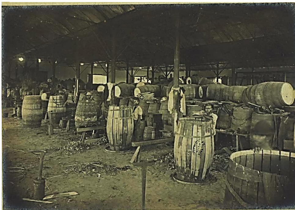
Figura 28 - Visão interna do setor de tanoaria da Companhia Alcolica da Bahia
