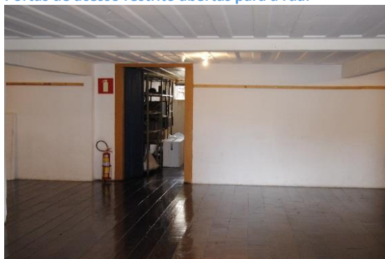
Figura 21: Falta de segurança no Museu do Diamante. Portas de acesso restrito abertas para a rua.
