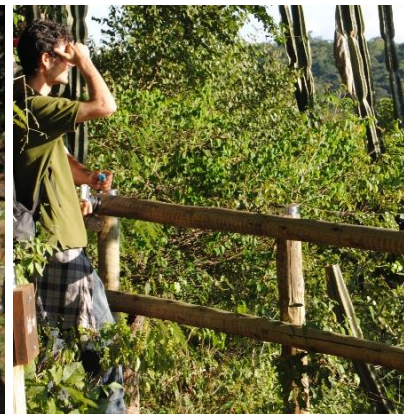
Figura 20: Corrim o e cercas de seguran a. Pared o, Lapinha, Lagoa Santa.
