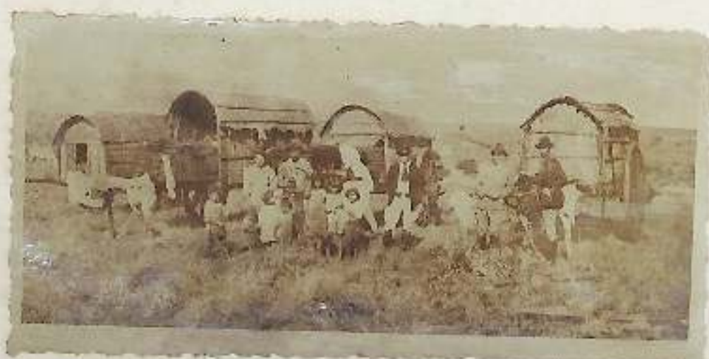
Carretas que transportavam material de Santo Angelo para São Nicolau durante a construção do novo quartel hoje inexistente
