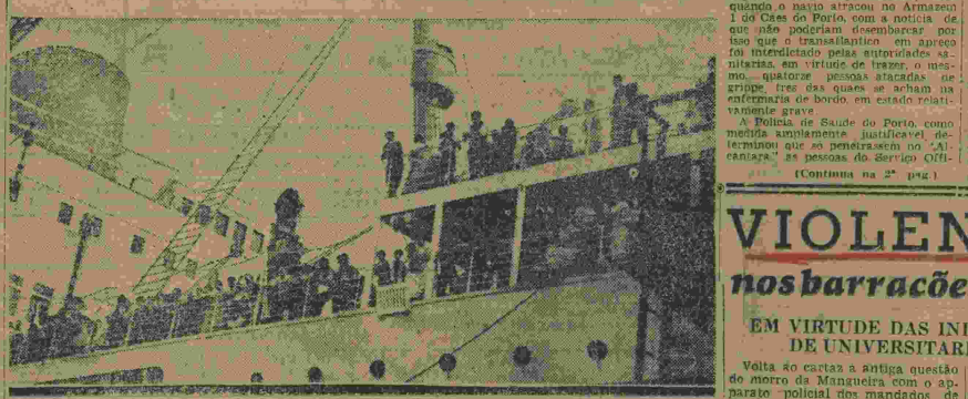
O «Alcantara» atracado no porto, impedido pelas autoridades sanitarias
